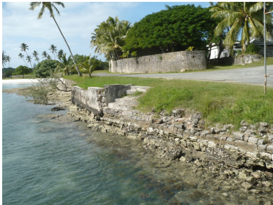
Photo ci-dessus : 1. Détail du mur A, au niveau de l'escalier. Cette zone est particulièrement abîmée, et il semble que l'on trouve plusieurs époques de construction car on y trouve au moins 2 types de maçonneries.
