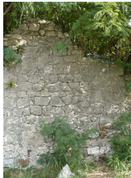
Photo ci-dessus : 8. Détail de la maçonnerie. Les joints sont creux et laissent apparaître le mortier de pose, la végétation prend racine, les pierres se déchaussent et finissent par tomber.
