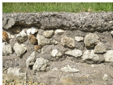
Photo ci-dessus : 1. Détail du mur A, au niveau de l'escalier. Cette zone est particulièrement abîmée, et il semble que l'on trouve plusieurs époques de construction car on y trouve au moins 2 types de maçonneries.
