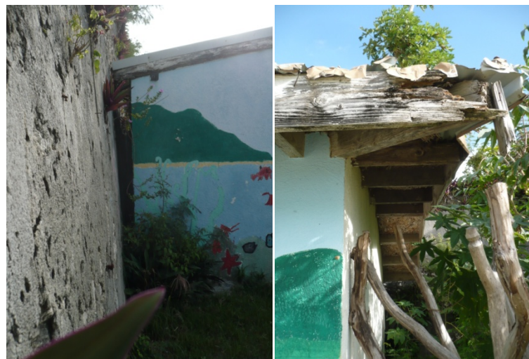
Photo ci-dessus à gauche : 16. Détail de l'arrière du bâtiment, les constructeurs ont laissé un espace entre les 2 murs par où l'eau de la toiture s'écoule. Ceci a pour effet de saper la maçonnerie par l'effet des infiltrations et des remontées capillaires.
