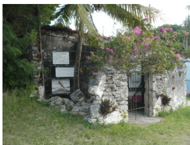
Photo ci-dessus à gauche : 13. Détail des désordres de l'appentis, le mur Est est en partie effondré et un cocotier pousse à l'intérieur. À noter que des panneaux d'informations historiques sont installés dans cette pièce.
