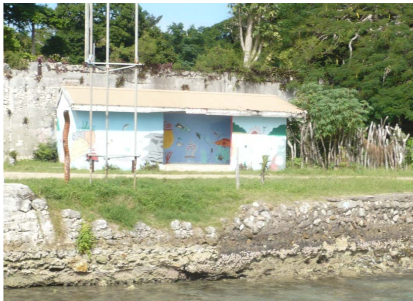
Photo ci-dessus : 15. Vue d'ensemble du bloc sanitaire, façade Nord-ouest. Cette construction cache la moitié Ouest du mur D, il remplace une construction en appentis dont les traces sont encore visibles sur le mur en pierre.
