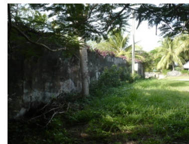
Photo ci-dessus à droite : 14. Vue d'ensemble de la partie arrière (façade Sud-est). Le niveau du sol se trouve à environ 1.5m au dessus par rapport à l'autre côté. Le couronnement du mur est envahi par la végétation.
