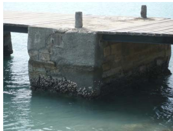
Photo ci-dessus : 6. Détail de la pile n°1 façade ouest. Comme sur les 3 autres piles, les angles en pierre de taille ont été détruits et remplacés par du béton.
